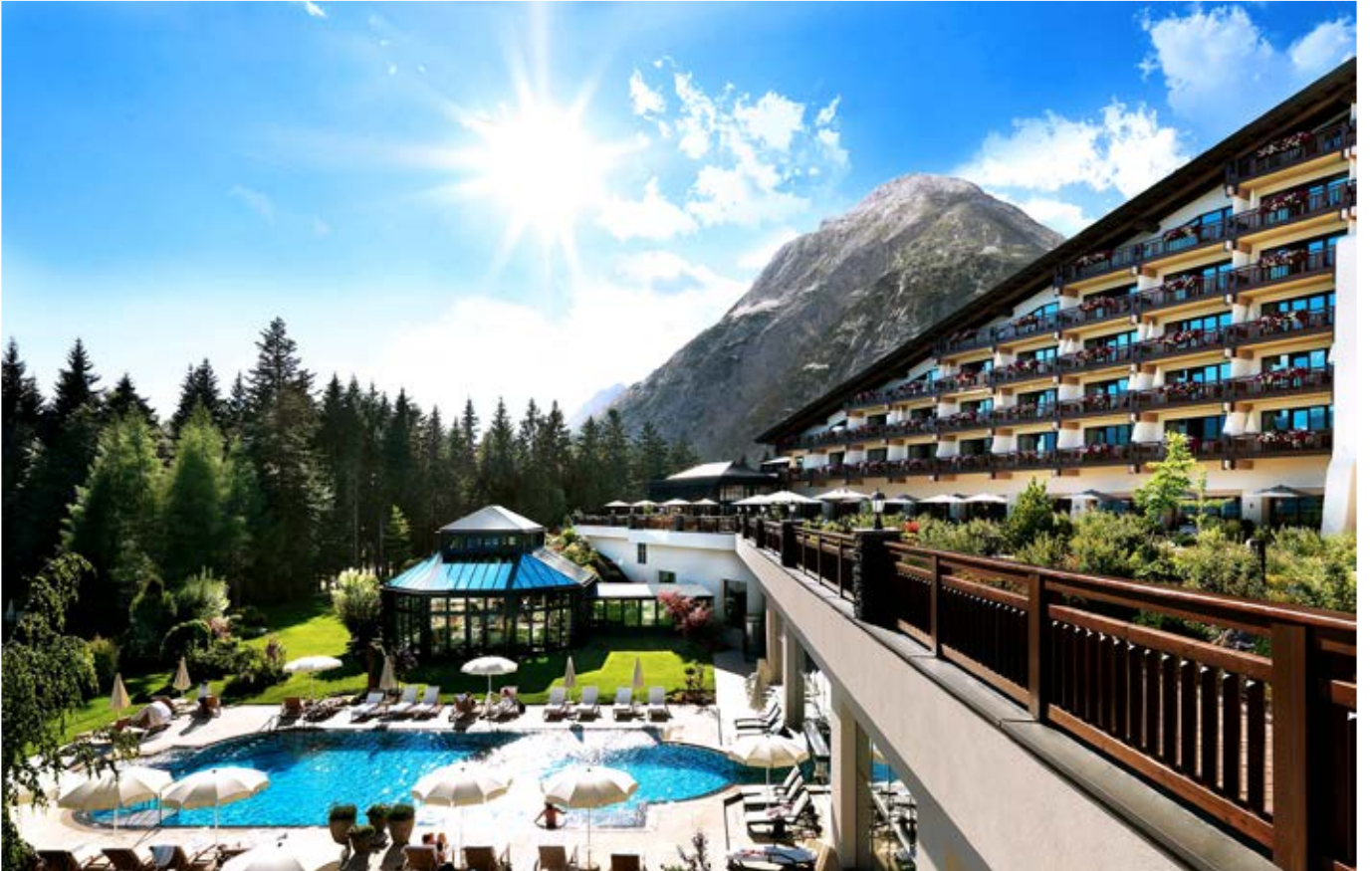
Interlpen-Hotel Tyrol, Telfs (Austria)
